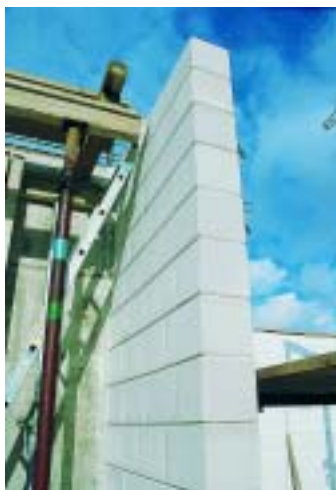
Durch den Einsatz von weißem Dünnbettmörtel, der für Stoß- und Lagerfugen eingesetzt wird, entstehen sofort saubere Sichtmauerwerksflächen.
