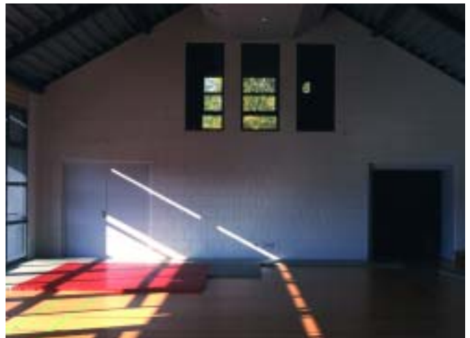
Das Mauerwerk ist so gut wie wartungsfrei. Es wurde mit einem biologisch, umweltfreundlichen Mineralfarbanstrich versehen – Farbton Papyrusweiß – RAL 9018. Verschmutzungen lassen sich einfach entfernen.
