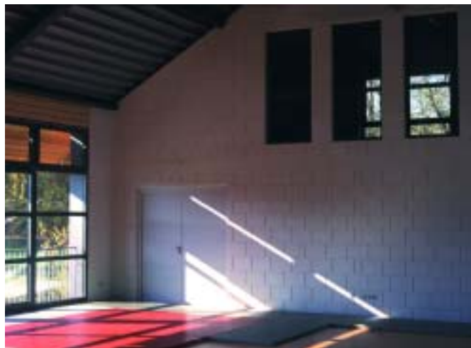
Architekt Roetzer: „Mit dem KS-Fasenstein hat der Bauherr zeitlose Innenarchitektur erhalten, die auch in 20 Jahren noch ansprechend, attraktiv und belebend sein wird.“
