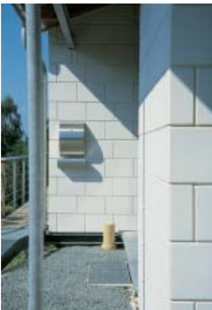
Die Produktpalette bietet End- und Pass-Steine mit einer glatten Stirnseite. Mit diesen Elementen ist jeder Mauerabschluss absolut sauber und glatt herzustellen.
