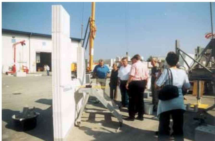
Nach erfolgter Elektroinstallation überzeugen sich Besucher von der glatten und ebenen KS-Quadro E-Wand.
